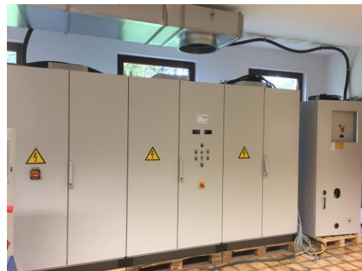
Abb. 7: 100 kW Anlage mit 1200 A, 100 V
