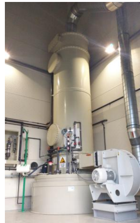
Abb. 1: chem. Absorptionswäscher zur Geruchsmin- derung für 10.000 \text{Bm}^3/\text{h}
