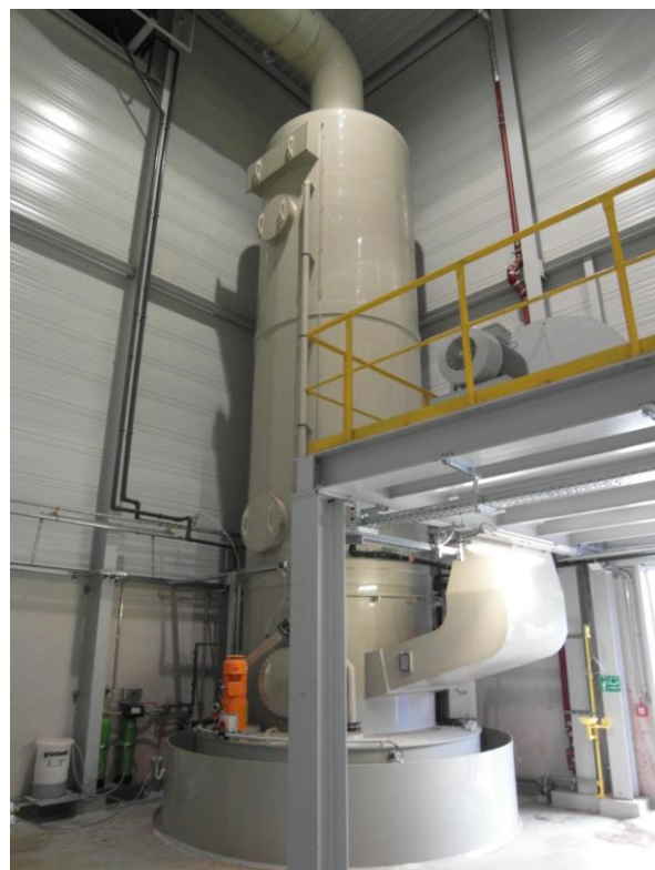
Abb. 3: Aminwäscher für 50.000 Bm 3 /h
