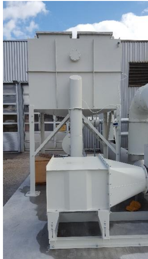
Abb. 1: Aktivkohlefilter zur Geruchsminderung für max. 2500 m 3 h Rohgas
