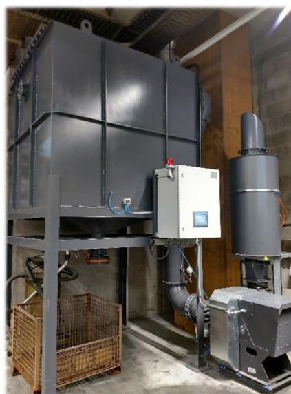
Abb. 2: Aktivkohlefilter zur Geruchsminderung für max. 3.000 m 3 /h Rohgas
