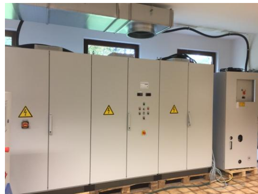
Abb. 7: 100 kW Anlage mit 1200 A, 100 V
