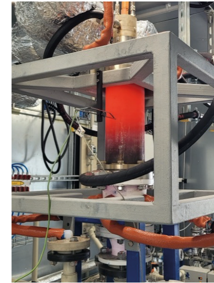
30 kW Plasmaanlage zur FCKW Entsorgung
